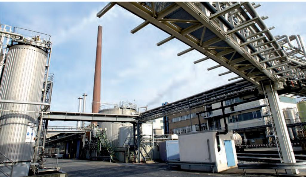
In den Anlagen von Evonik und Solenis am Standort Krefeld werden auf Basis verschiedener verfahrenstechnischer Prozesse, wie beispielsweise Reaktionen, Destillationen und Filtrationen, Produkte hergestellt, die zum Teil in den direkten Verkauf gelangen, aber auch als Rohstoffe in den eigenen Anlagen weiterverwendet und am Standort gelagert werden. Die Mitarbeiter der Logistik sorgen für die Bereitstellung, Abfüllung und den Transport der Produkte am Standort.
