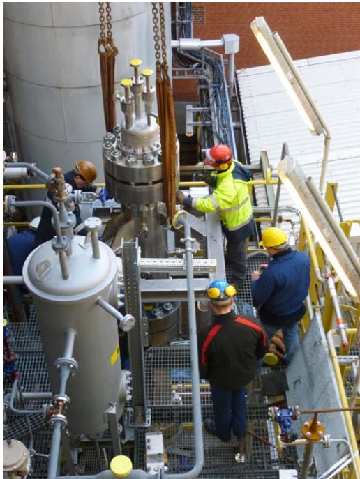
Foto: Aufbau der Blasensäule in der Versuchsanlage im Technikum des Geschäftsbereichs Advanced Intermediates von Evonik in Marl (Foto: Evonik Industries AG)
