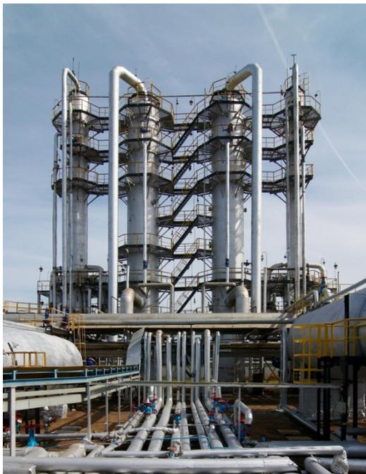
*Bildunterschrift:* Industrielle Gasanlage, in der CAPLUS® zur Sauer gaswäsche verwendet wird (Quelle: Gulnaz Yaminova)
