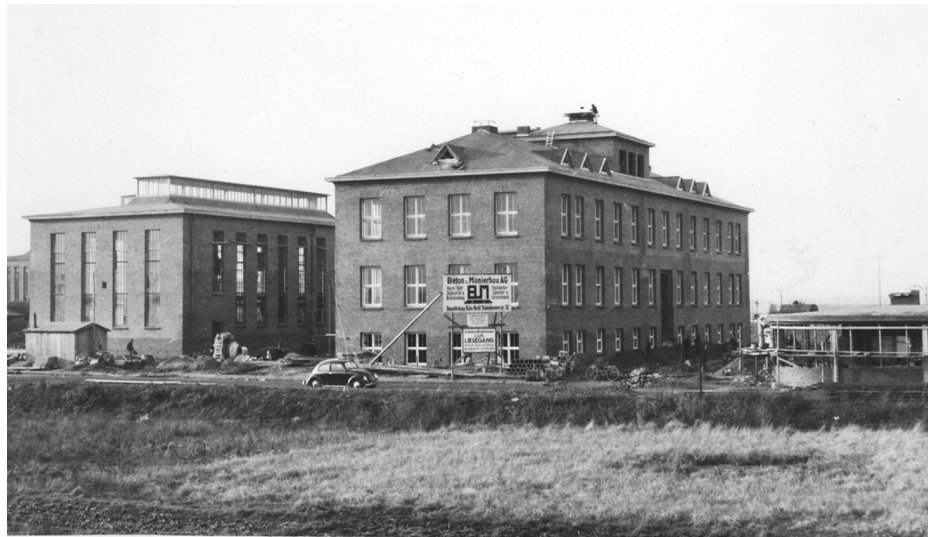
Blick vom heutigen Parkplatz auf das Technikum, das Labor und die Pforte.
